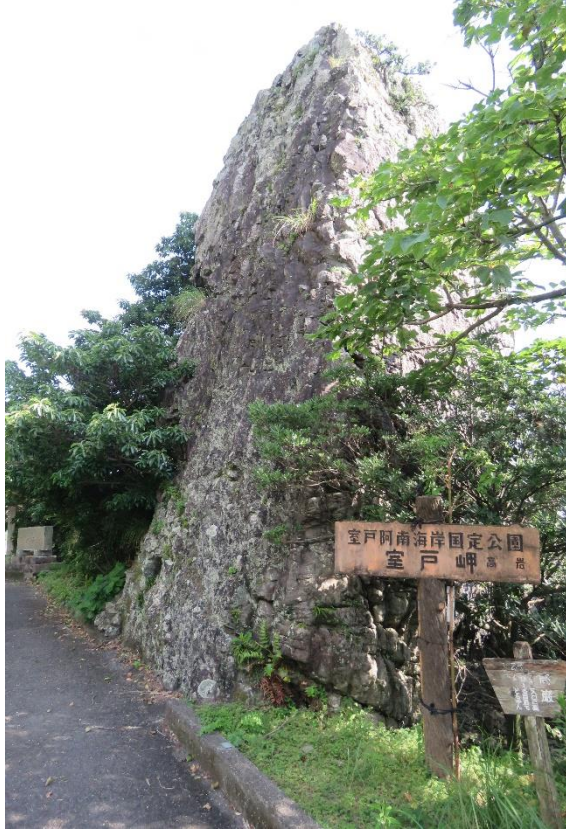
国道の拡幅で一部掘削された高岩（p40）
