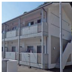
市営第二大谷団地2号棟建替事業
